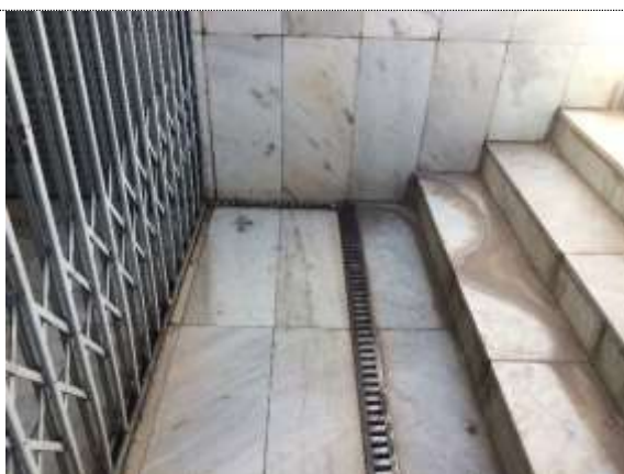
Fotografia 18: Vista da grelha do ralo linear da escada de acesso aos plenários ;
