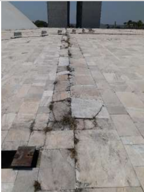
Fotografia 27: Vista da junta de dilatação estrutural, junto a cúpula do Senado Federal;
